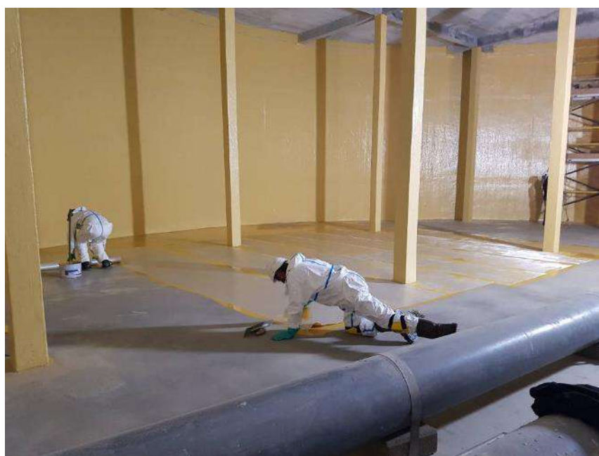
Mise en œuvre du revêtement d'étanchéité – réservoir de La Croix
