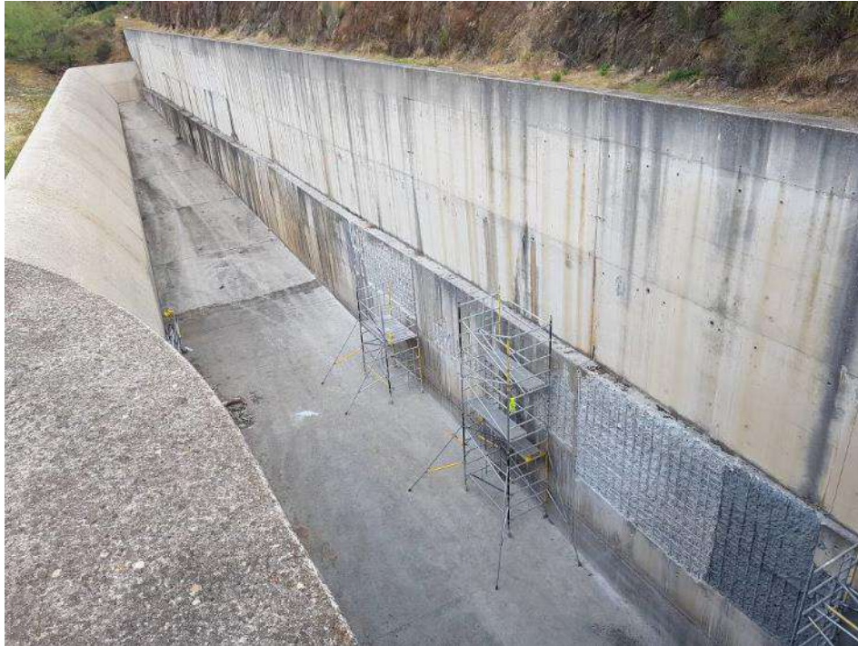
Traitement des épaufrures de l'évacuateur de crue, barrage de la Verne
