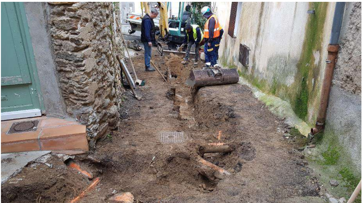
Travaux de renouvellement de la rue Vieille Caserne
