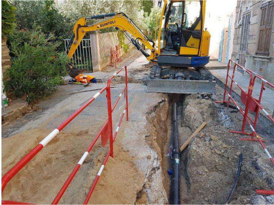
Travaux de renouvellement du chemin Bellevue
