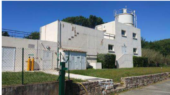
Usine de la Gisle
