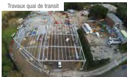
Travaux quai de transit
