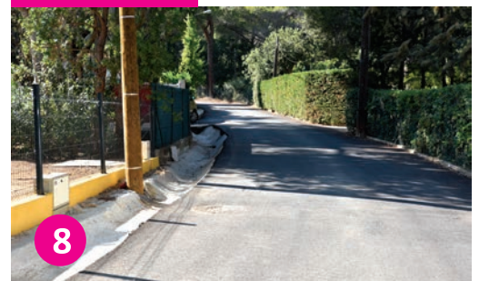
Contrairement à ce qui a été indiqué dans le précédent Mag, la réhabilitation des eaux usées s'est faite dans la rue J.J.Rousseau et non pas dans l'allée du Petit Pont.
