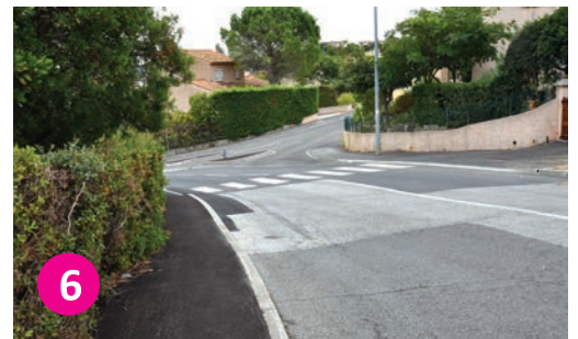
Traitement de sol en enrobé d'un trottoir assurant la liaison piétonne entre l'avenue de l'Eau vive et celle de Frais vallon.
