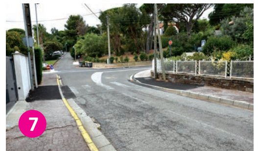
Mise en place de bordures surbaissées pour faciliter l'accessibilité aux usagers rue de la Pépinière
