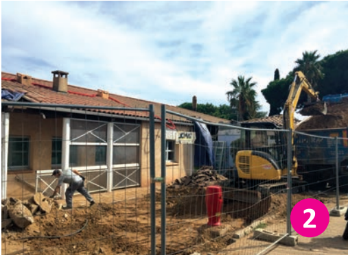
Rénovation de la façade principale de la crèche
