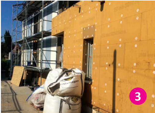
Création de l'extension de la crèche, située sur l'impasse Eugène Decanis.
