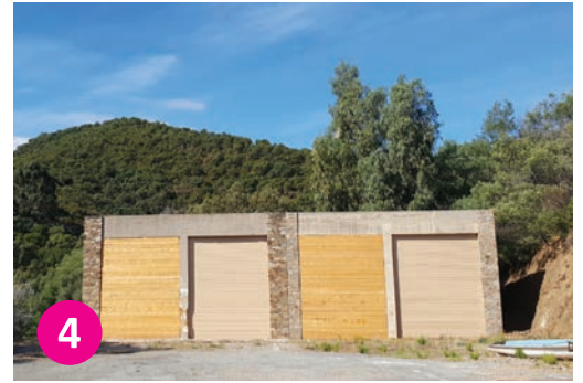
Mise en sécurité du site de l'UTOM avant l'engagement des travaux définitifs qui débuteront début 2019.
