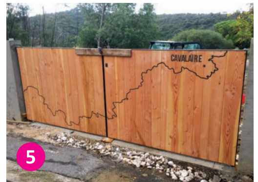
Mise en place d'un des portails de l'Usine , avec incrustation en métal du trait de côte de la Corniches des Maures.
