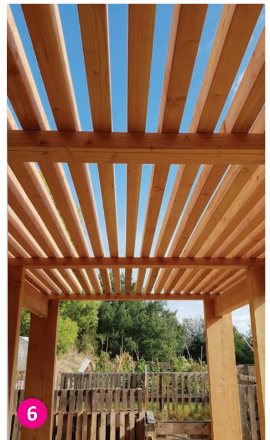
Installation d'une pergola au potager de l'usine ayant pour objectif d'accueillir les visiteurs à destination du domaine Foncin.
