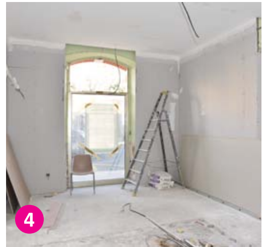
4 Gare routière : réfection du plafond - Isolation intérieure des murs après agrandissement réalisé en ôtant les cloisons non porteuses.
