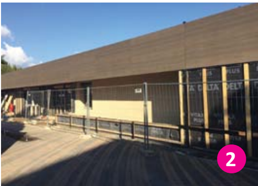
Extension de la crèche municipale côté placette réalisée en structure bois dans l'attente du bardage définitif.
