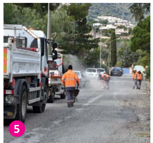
5 Campagne de «trous» : l'entreprise Eiffage, dans le cadre du marché d'entretien de voiries, réalise régulièrement des journées dédiées à la réfection de «nids-de-poule» sur les voies publiques de la commune.
