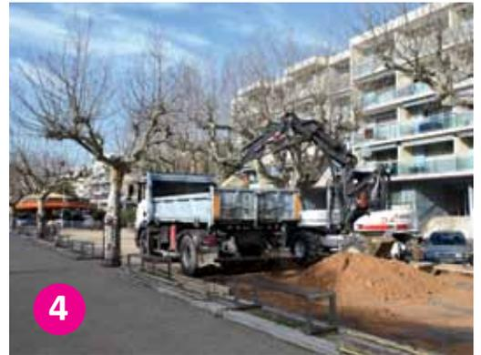
**Travaux de remise en état du terrain de boules de la place Benjamin-Gaillard : travaux de remplacement du sable par des gravillons calibre 0-6.**
