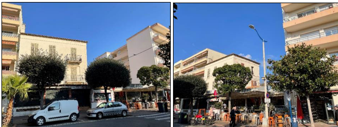
Vues depuis l'avenue des Alliés (source : EPF PACA)
