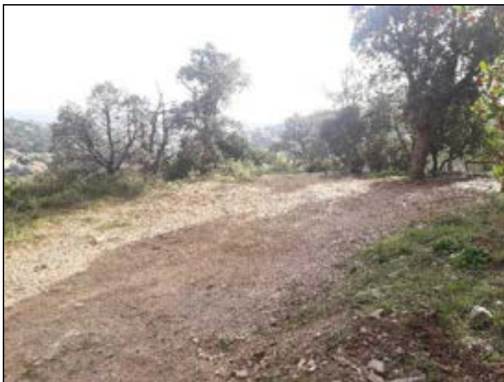
Piste et dépôt de remblais- zone décapée
