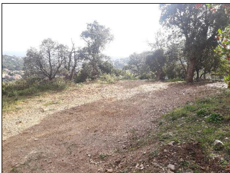
Piste et dépôt de remblais- zone décapée
