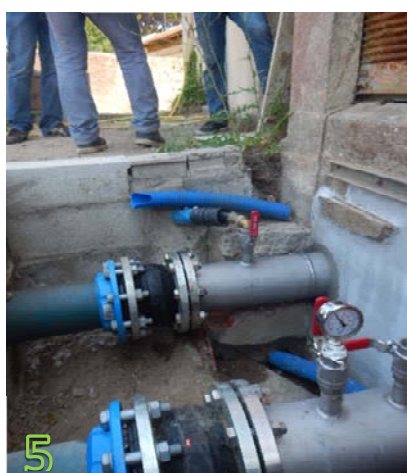
1 - Vue de la plaque signalétique des réservoirs. 2 & 3 - Vue des débitmètres. 4 - Vue des électroniques de mesures. 4 & 5 - Vue ds prises de pressions.
