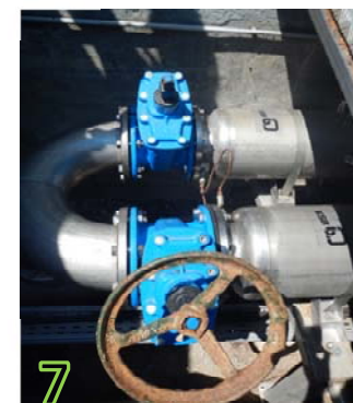
1 - Vue du réservoir Hameaux. 2 - Vue de l'alimentation (conduite centrale) et de la distribution (conduite la plus à gauche). 3 - Vue de l'armoire de télégestion. 4 & 5 - Vue de l'hydrobloc de régulation. 6 - Vue de la conduite d'alimentation des accélérateurs (conduite inox). 7 & 8 - Vue des deux accélérateurs.
