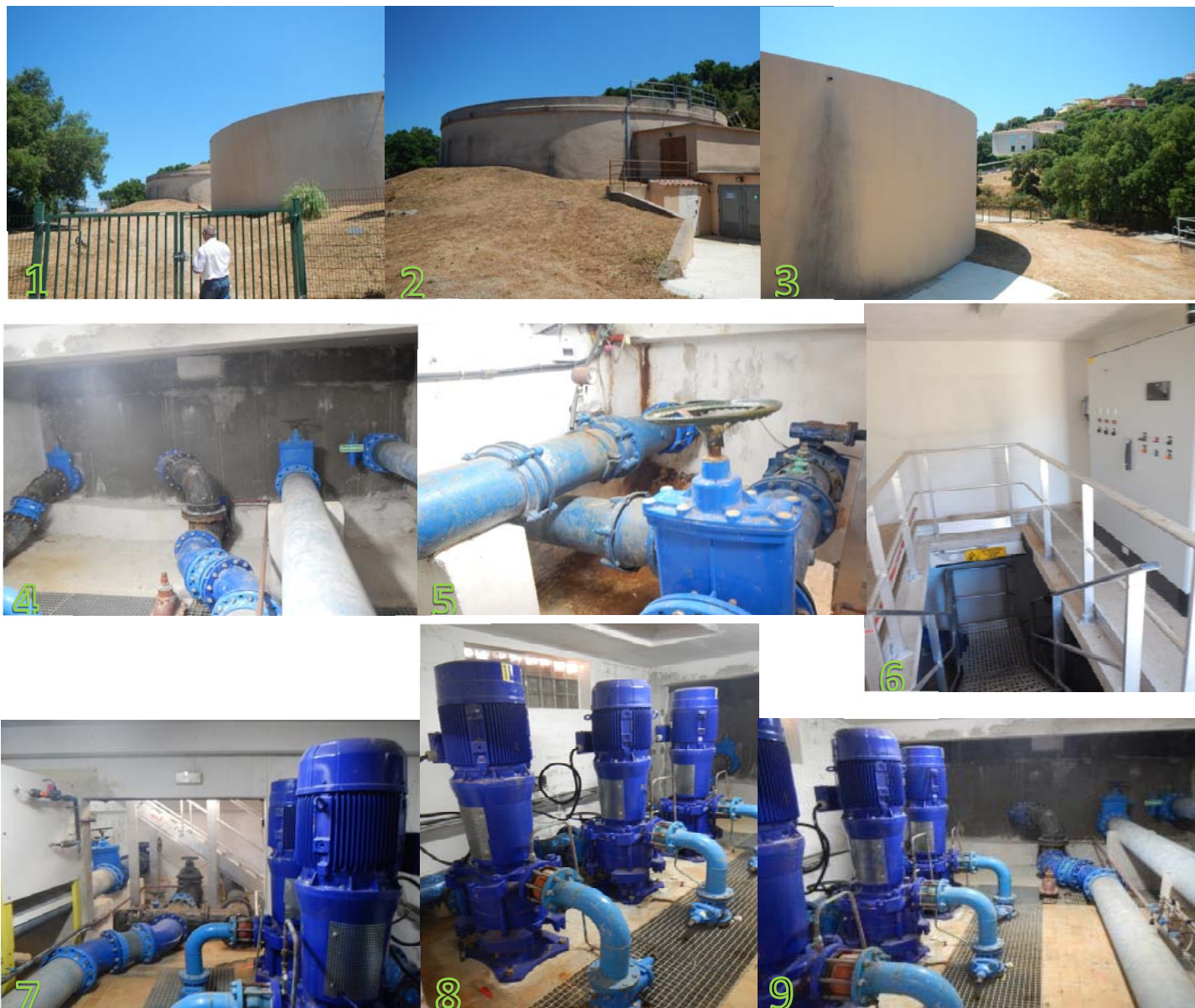
1 & 2 & 3 - Vue extérieure du réservoir Le Noyer.
