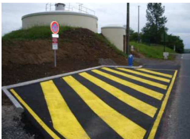
Plate forme d'aspiration sur une réserve d'eau équipée d'un poteau d'aspiration de 100 mm
