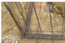
Nœud de chaînage - Continuité mécanique
