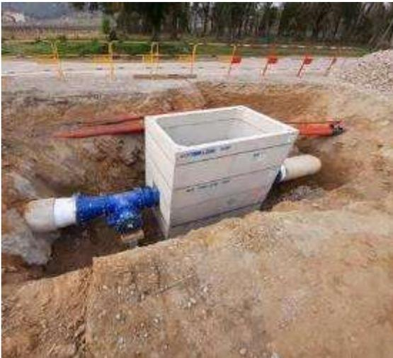
Mise en œuvre d'un débitmètre DN400 mm sur le réseau de transfert usines Vernes/Môle, entrée usine de Cogolin mars-2021. Regard béton 2500\*1500 mm.
