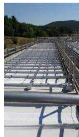
L'efficacité de ces couvertures est avérée car il était primordial de remédier au développement des algues qui impactait d'une part la structure des lamelles de décantation par leur poids, et d'autre part le passage de l'eau à travers les lamelles par obstruction, dégradant de fait la décantation et contribuant à diminuer les performances de cette étape de traitement.
