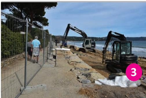
Travaux de confortement de l'ancienne voie de chemin de fer, par remplacement des enrochements
