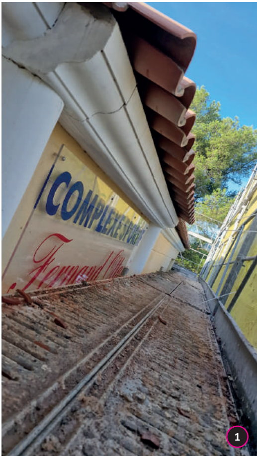
Complexe Ottavi Rénovation de la toiture
